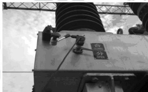
35KV SF6 开关传感器安装
