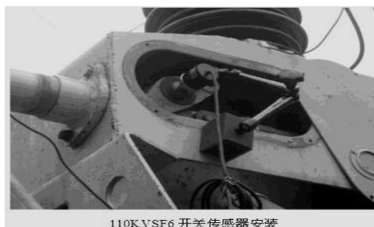
110KV SF6 开关传感器安装
